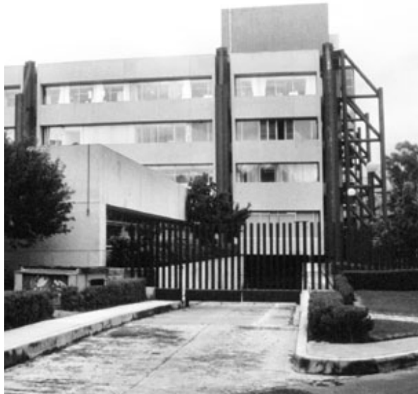
Figura 5.2 Refuerzo de estructuras con elementos de contrafuertes.
