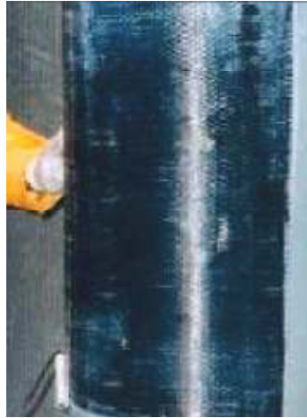
Figura 5.6 Columna encamisada con fibras de carbón
