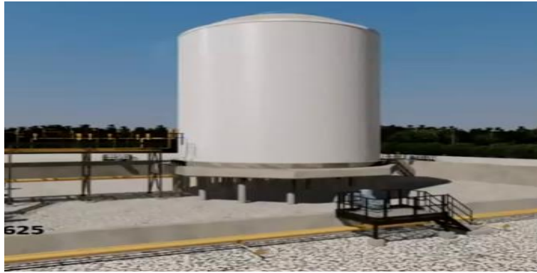
Figura 3. Tanque de almacenamiento de GNL
