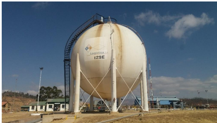
Figura No 24: Tanques esféricos de GLP para interfase
