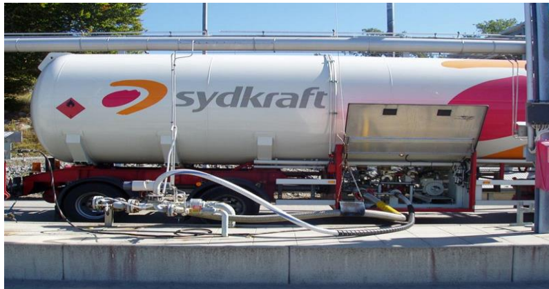
Figura No 4: Proceso de descarga de GLP
