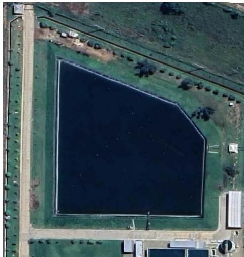
Figura 2.28: Vista de la Laguna de Almacenamiento de Agua
