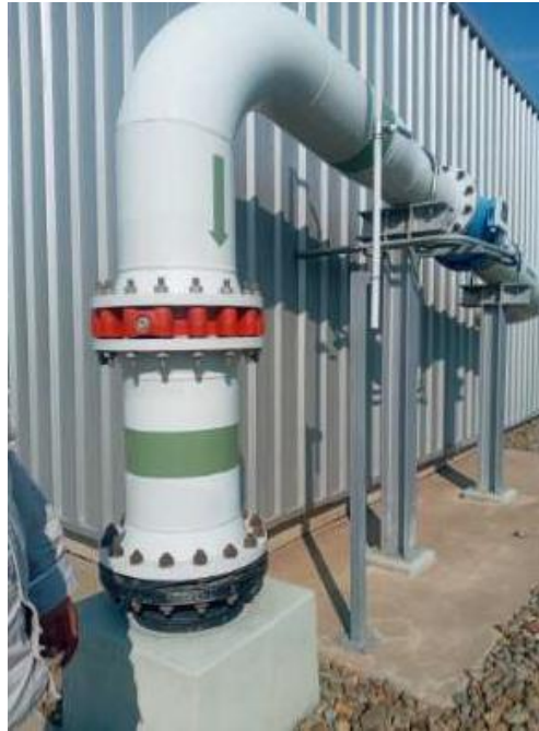
Figura 2.30: Vista del Tramo de Ingreso a la Torre de Enfriamiento
