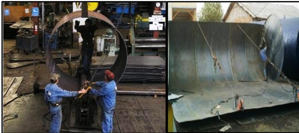
Figura 19: Construcción del cuerpo del cilindro del tanque.
