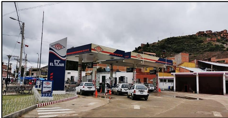
Figura 7: Vista de la estación de servicio de combustible “El Tejar”.
