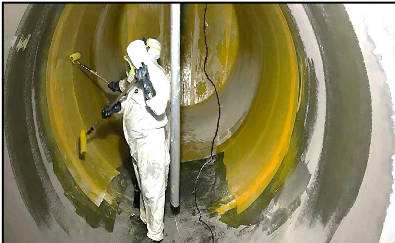
Figura 17: Aplicación de revestimiento en reparación de tanques.
