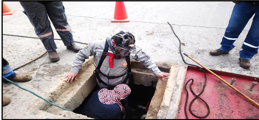
Figura 11: Limpieza en tanques subterráneos de combustibles líquidos.
