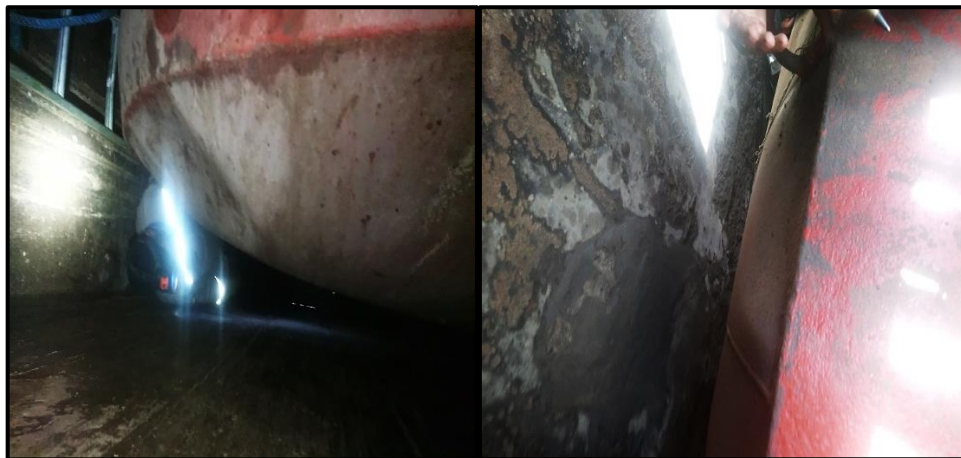
Figura 10: Inspección de vida útil de tanque subterráneo Estación El Tejar.
