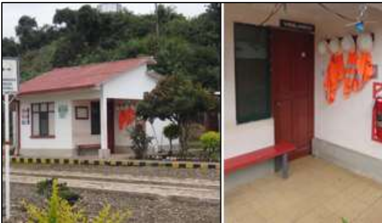
Figura 12: Área de control y vigilancia.
