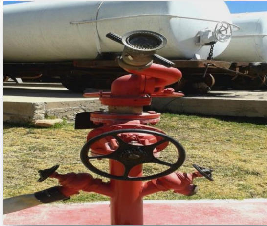
Figura N° 8: HIDRANTE-MONITOR #1
