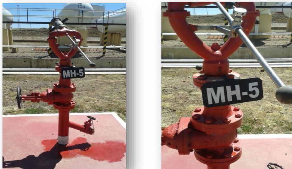
Figura N° 12 Hidrante-Monitor #5
