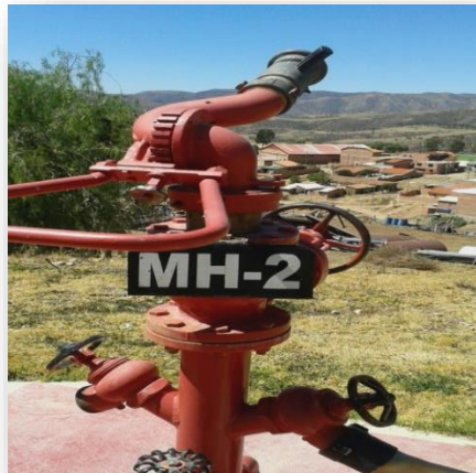
Figura N° 9 Hidrante-Monitor #2
