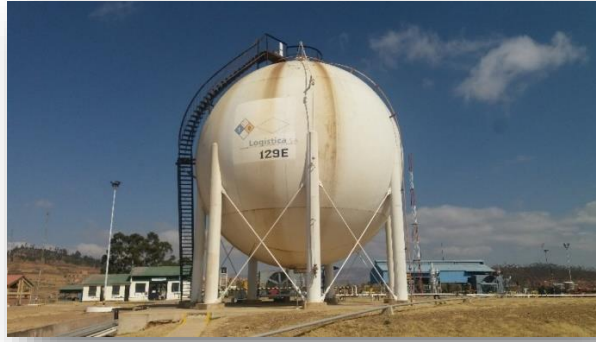
Figura N° 6 Tanques Esférico de GLP para Interfase
