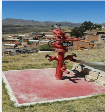
Figura N° 9 Hidrante-Monitor #2
