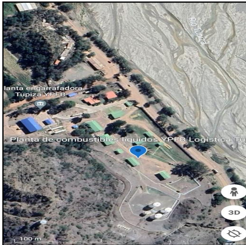
Figura 7: Ubicación de la planta de combustibles líquidos YPFB Tupiza
