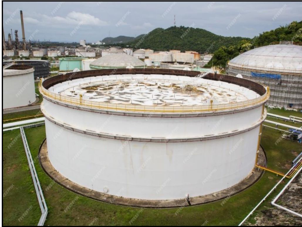
Figura 5: Tanque de almacenamiento con techo flotante
