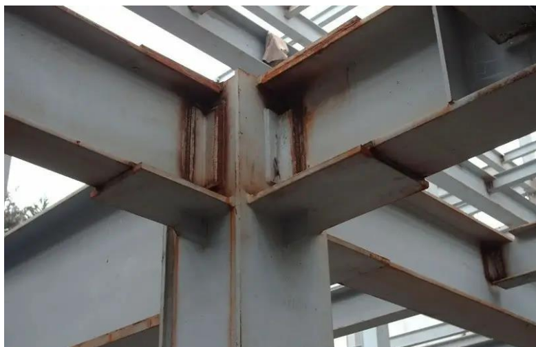
Figura 2. Conexión soldada (▷ ¿Conexiones soldadas o Atornilladas?, 2024)
