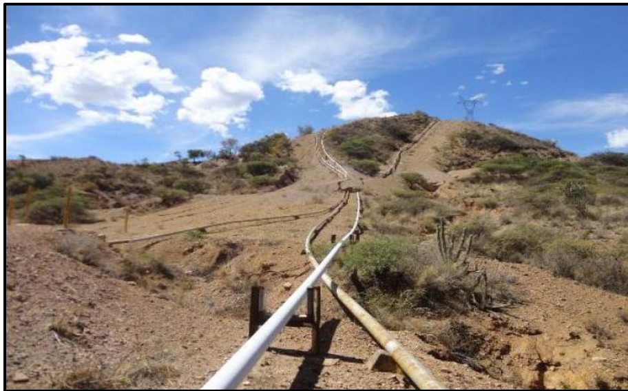
Figura 1: Tendido de la Línea PCSZ-1
