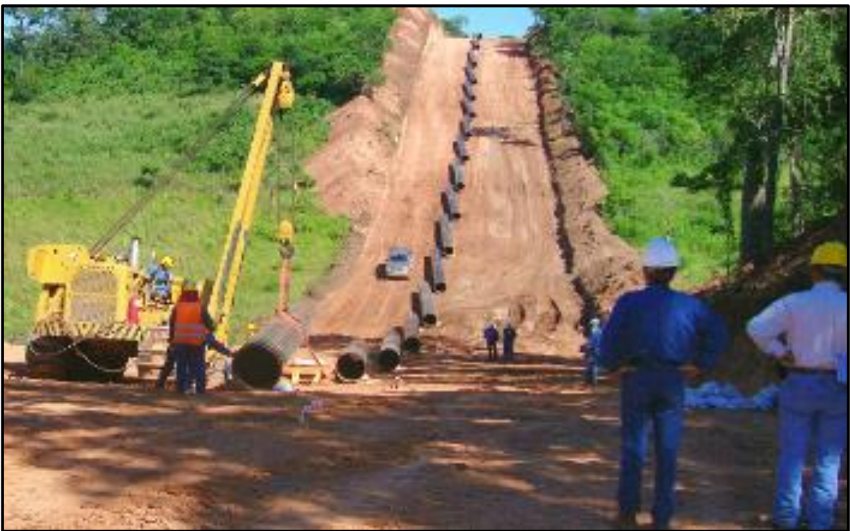
Figura 4: Desfile de tuberías
