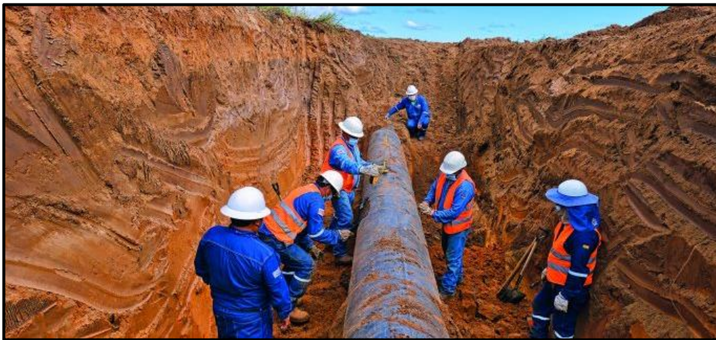
Figura 1: Inspección de ducto enterrado
