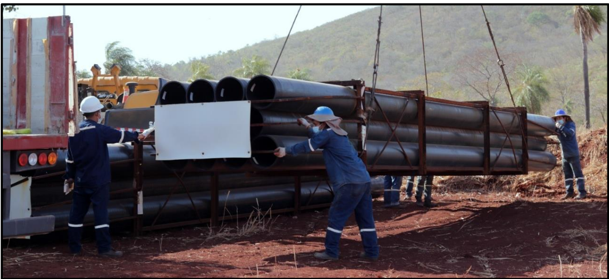
Figura 3: Acopio de tuberías
