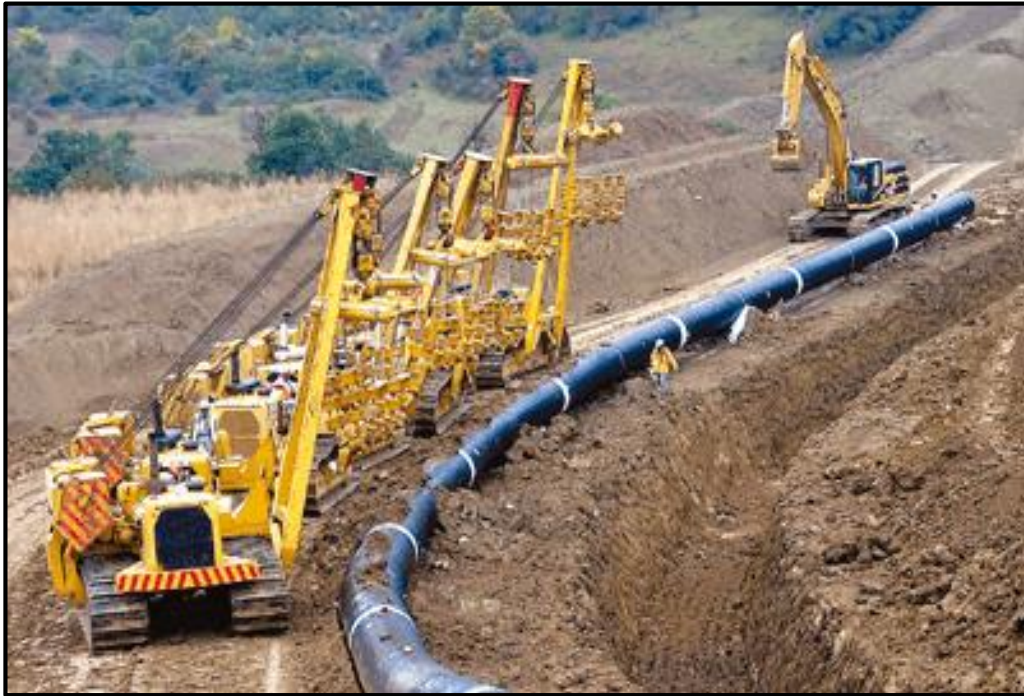
Figura 5: Curva en el trayecto de una línea de tuberías
