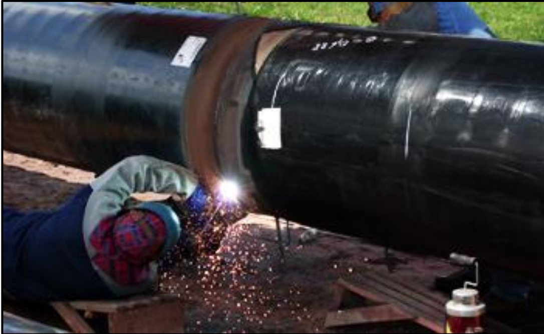
Figura 6: Soldado de tuberías
