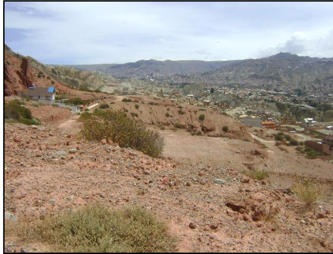
Figura No 2.2. VISTA PANORÁMICA DE LA ZONA DE OBRAJES
