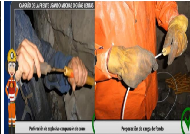
Figura 13: Perforado y unión de fulminante
