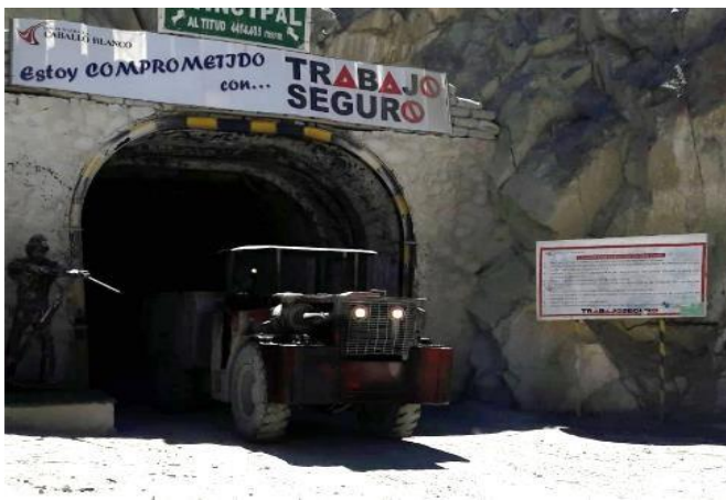
INGRESO (BOCAMINA) RESERVA
