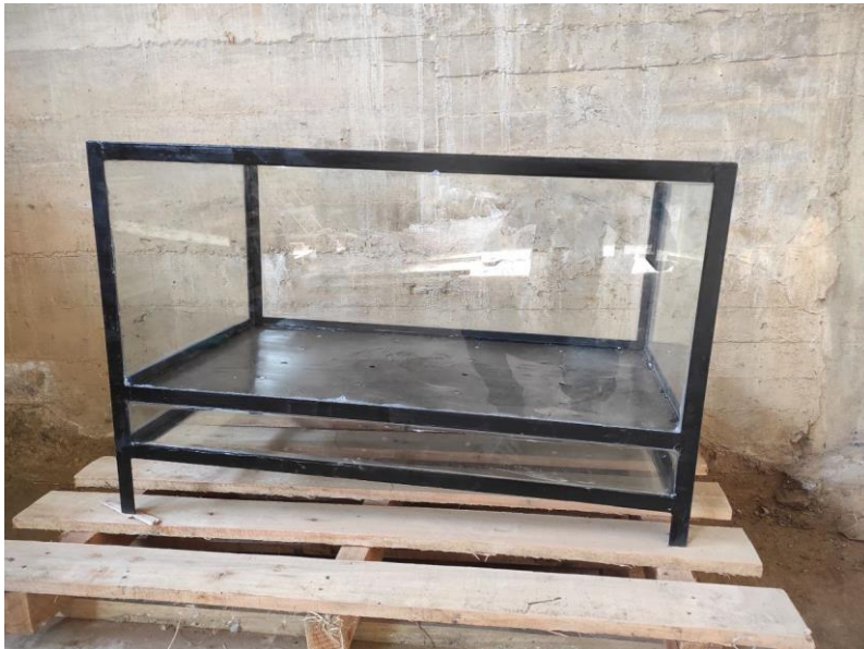
Ilustración 6 Construcción del lecho de secado piloto
