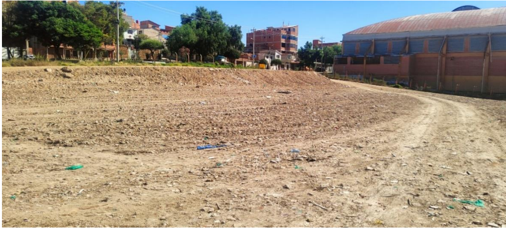
Fotografía 10: Zona de disposición de RCD compactada – Buzón Cementerio
