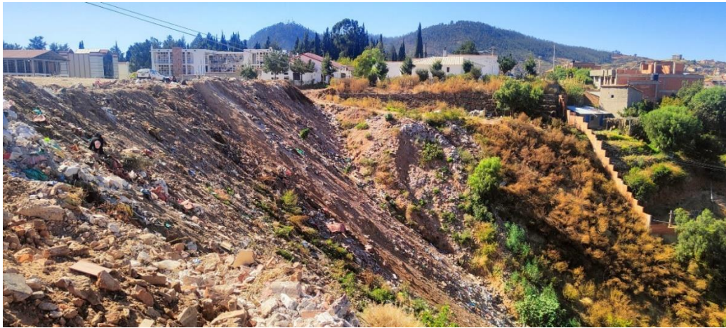
Fotografía 11: Zona para disposición de RCD, escombros – Buzón Cementerio
