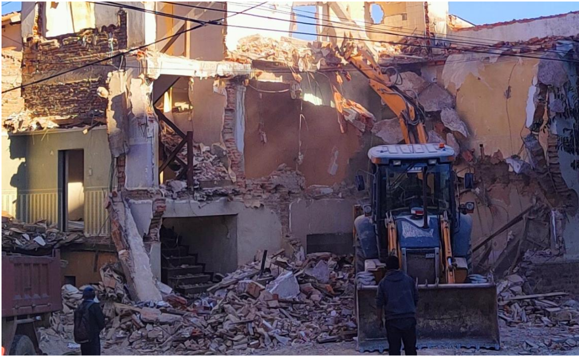
Fotografía 1: Demolición de Infraestructura – Vista Principal
