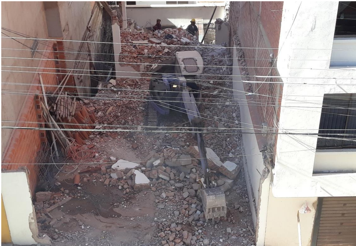
Fotografía 2: Demolición de Infraestructura – Vista Superior
