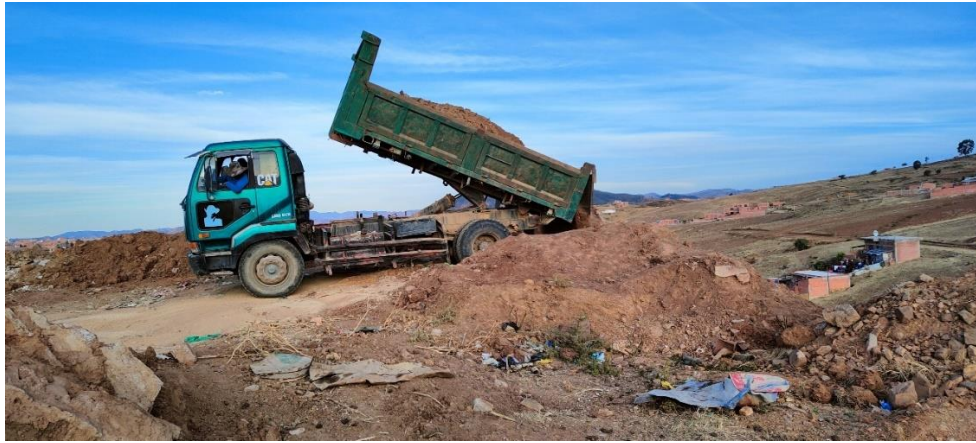
Fotografía 20: Empresa transportadora de Ecombros realizando disposición de RCD – Buzón MAKIBER
