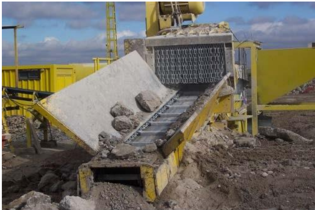
Imagen 3.7: Alimentador con bloques de RCD
