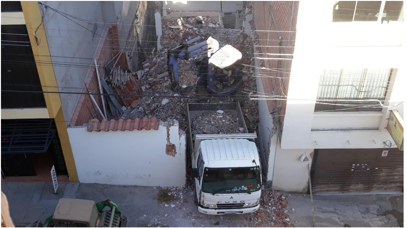
Fotografía 3: Retiro de Escombros y Carguío – Vista Superior
