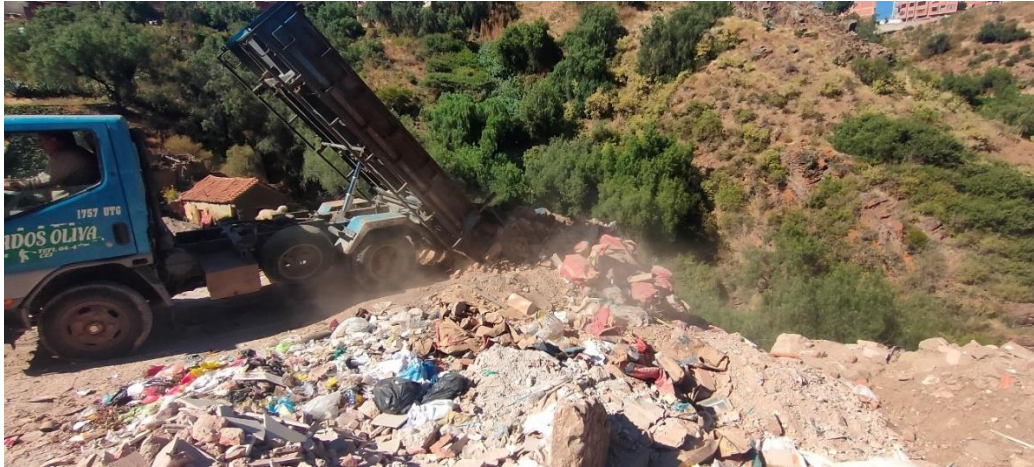
Fotografía 7: Empresa transportadora de Ecombros Oliva realizando disposición de RCD - Buzón Osvaldo Molina
