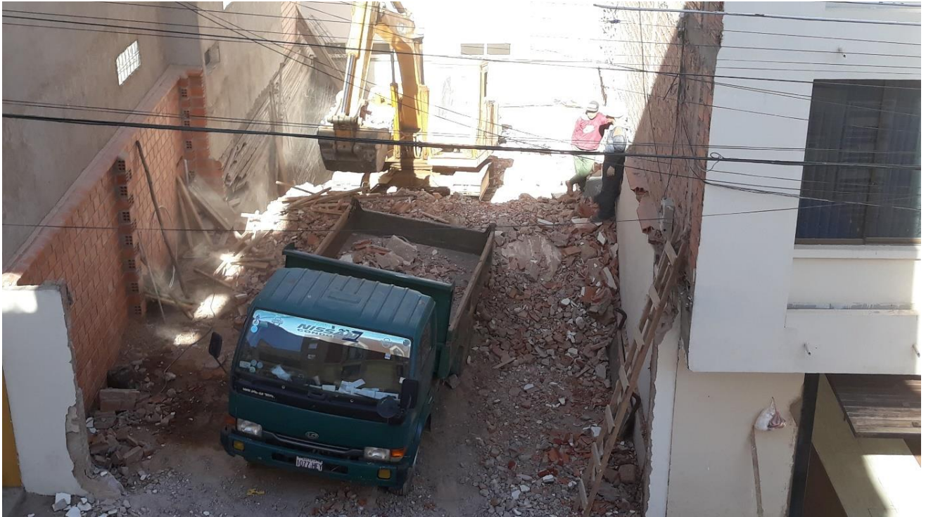
Fotografía 4: Retiro de Escombros y Carguío – Vista Superior
