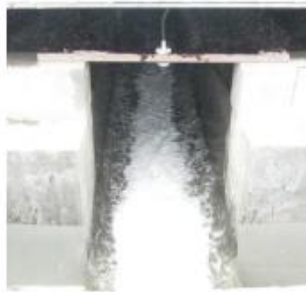
b) Canal recolector del efluente de los filtros
