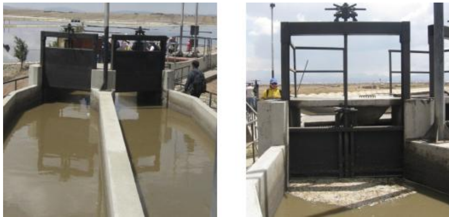
Desarenador de 2 compartimientos
