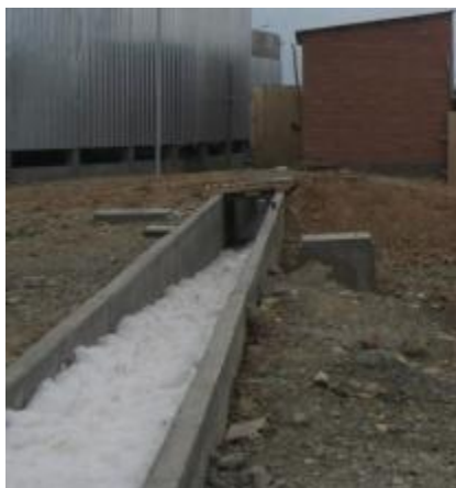
Figura 1.38: Espumas en el efluente de los filtros - Puchukollo.
