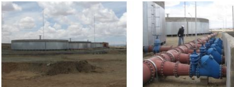
Figura 1.34: Sistema de distribución en los Filtros Percoladores de Puchukollo.
