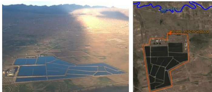
Figura 1.26: Ubicación de la PTAR Puchukollo.
