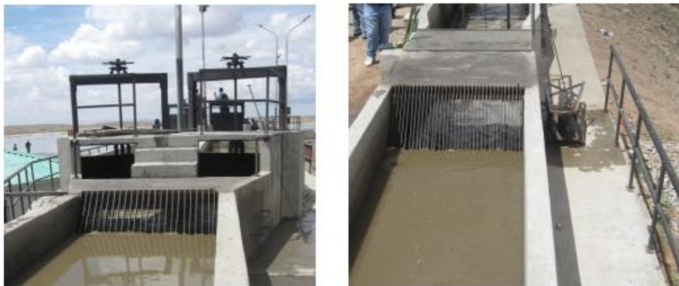
Figura 1.28: Rejas en la planta de Puchukollo.
