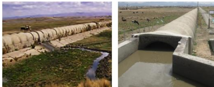
Figura 1.27: Emisario Principal de la PTAR de Puchukollo.
