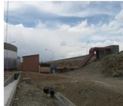
c) Canal de salida de los filtros. Cárcamos de bombeo hacia las lagunas
