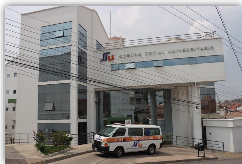
Fachada Principal Seguro Social Universitario
