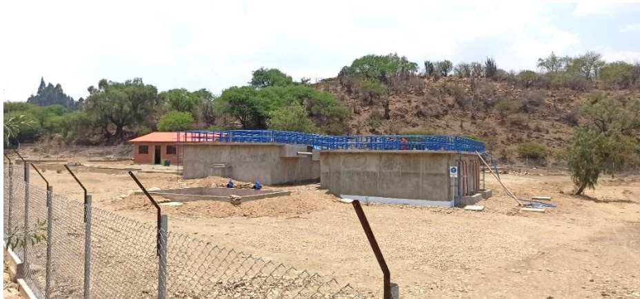
Foto N°2. Caceta de control, cerco perimetral y señalética
