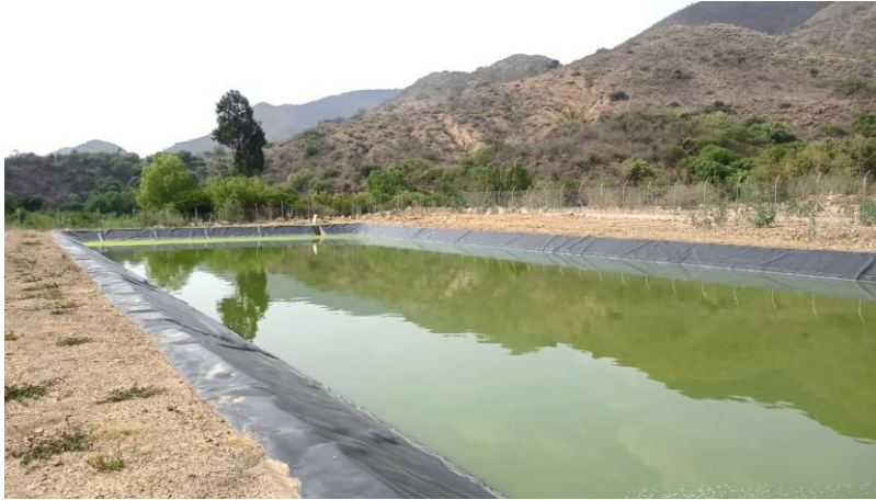
Foto N°5. Desarenador y paso By Pass
