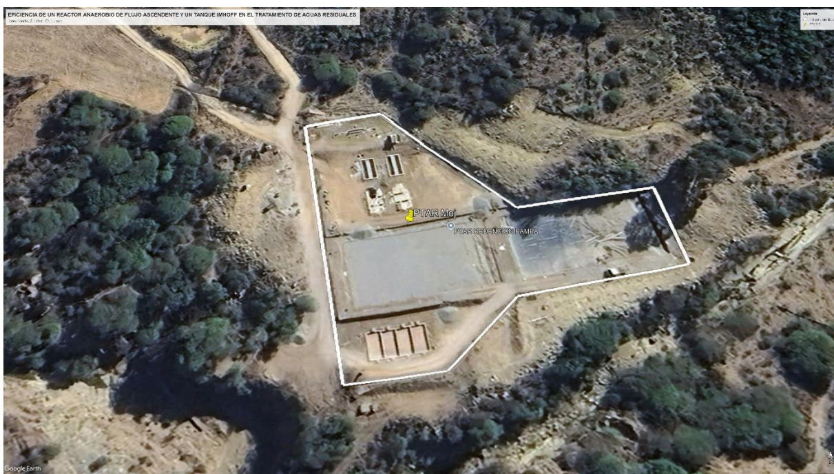
Imagen N° 9. Ubicación de la Planta de Tratamiento de Aguas Residuales
