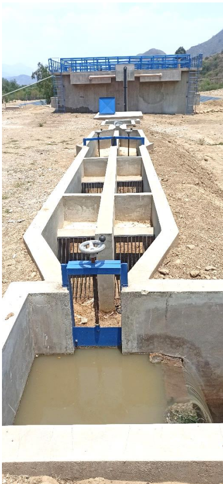
Foto N°5. Desarenador y paso By Pass
