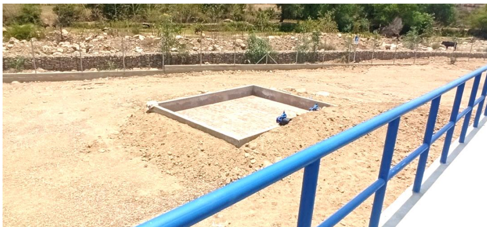
Foto N°3. Lechos de secado de lodos
