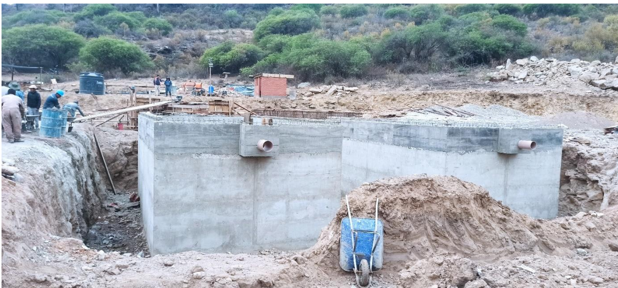
Foto N°7. Filtro Anaerobio de Flujo Ascendente
