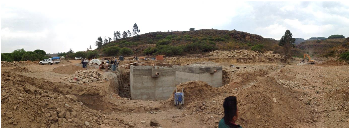
Foto N°7. Filtro Anaerobio de Flujo Ascendente
