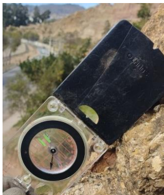
Ilustración 21. Medición del ángulo de inclinación del talud.
