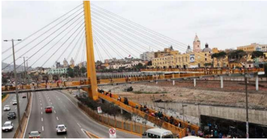
Figura 2.3: Puente Rayitos de Sol, Perú.
