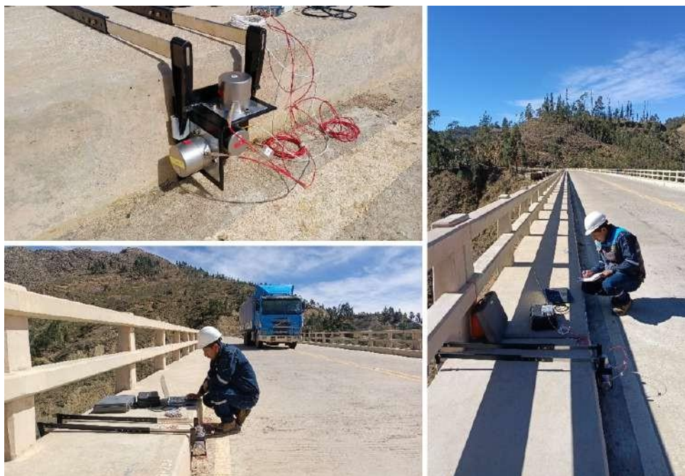
Figura 5.2: Registro de señales de vibración del puente.
