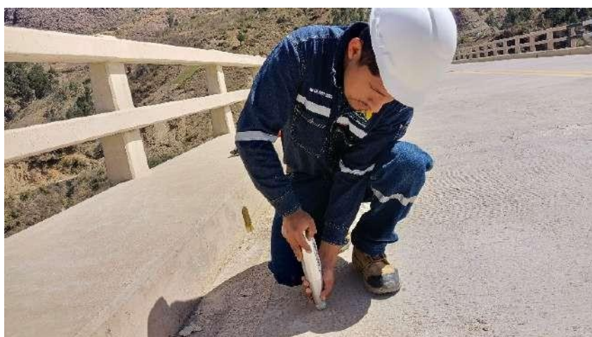
Figura 4.8: Ensayo de esclerometría aplicado al tablero del puente.
