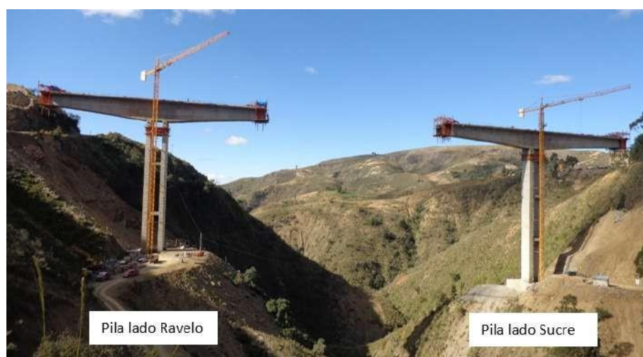
Figura 4.7: Proceso constructivo del puente Fisculco.
