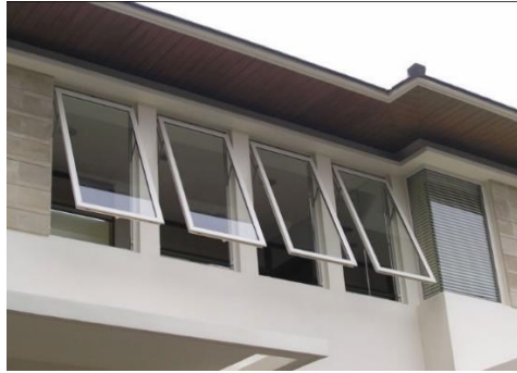
Figura 46. Ventanas proyectantes en sustitución de las ventanas tipo celosía. www.incerco.es
