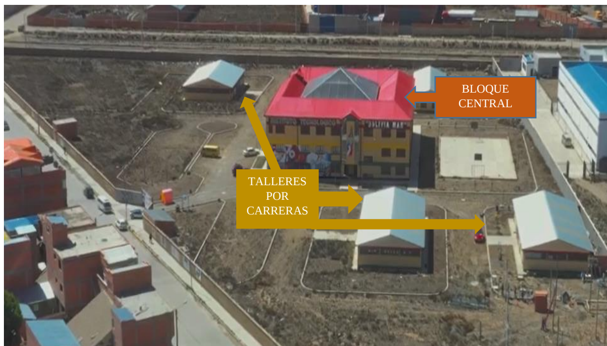
Edificaciones existentes actualmente en el ITBM
